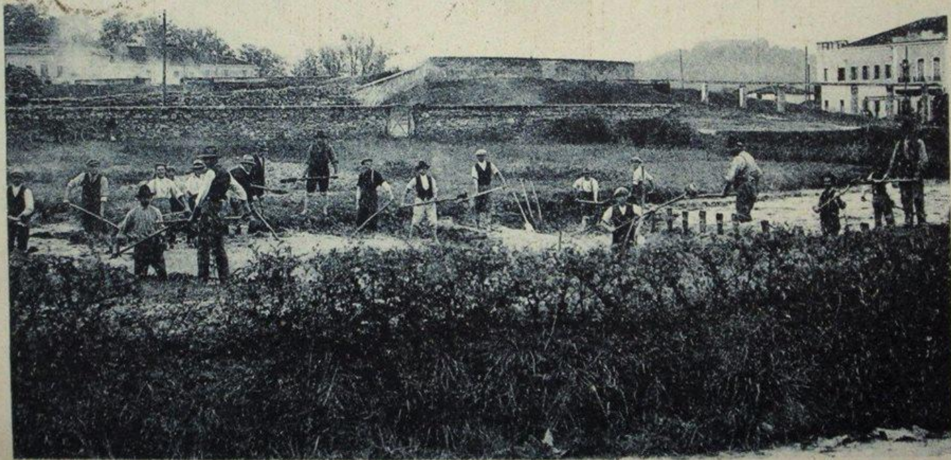
ABANO TERME (Padova) - Fonte principale Termale - Estrazione del fango da porsì nelle vasche di deposito
