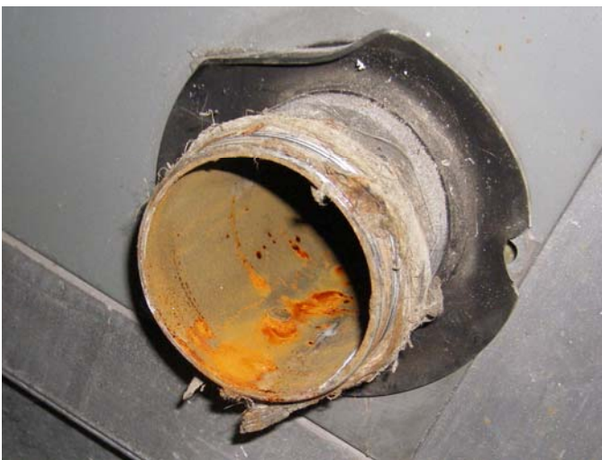
FIG. 18: CONCREZIONI SOSPETTE PER IL BIOFILM
